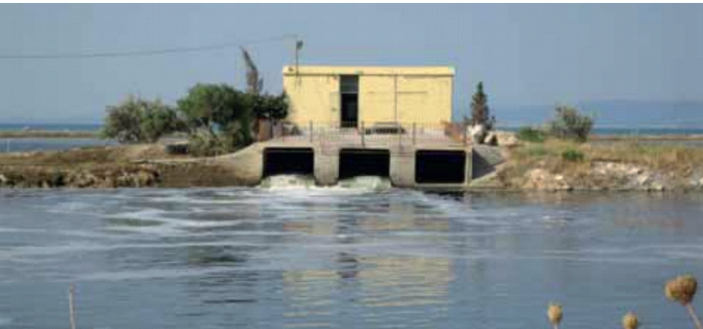
Yüksek tuzlulukta Homa Lagün suyunun tuzla işletme kanalına verilmesi.
